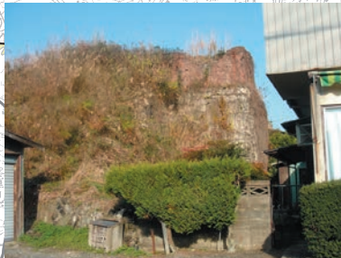
六坑坑口人車捲機の台座跡
