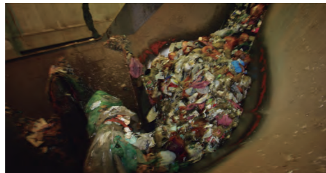
くらじクリーンセンターではごみを固形燃料化してエネルギーに変換しています
