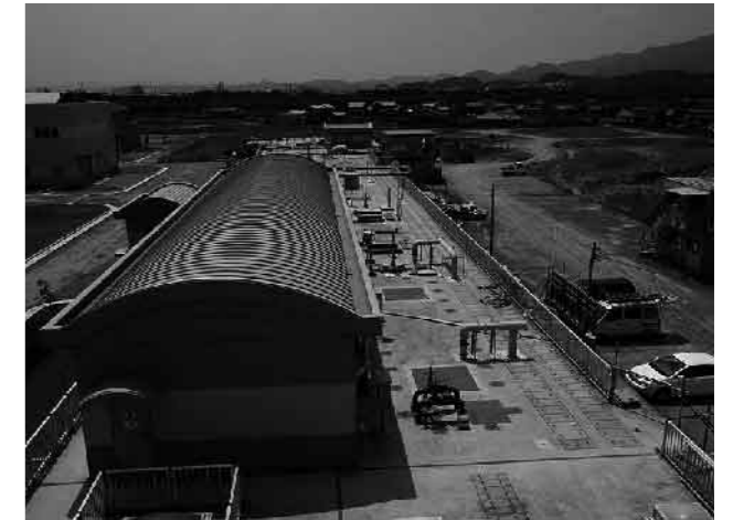
直方市にある遠賀川中流域浄化センターでは、宮若市、直方市、小竹町の汚水を浄化し、遠賀川に放流します。
