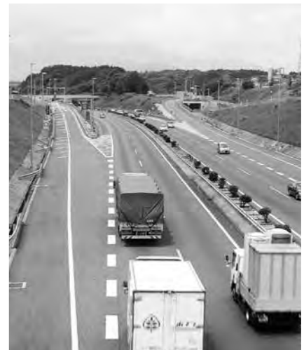
宮田スマートインターチェンジの整備により、北九州方面へのアクセスが向上しました。
