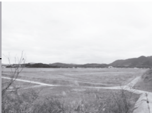
公共下水道も整備している磯光工業団地。誘致に向けて積極的にアピールを行っています。
