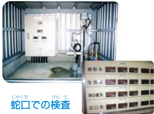
毎日検査 送り出す水道水に残留塩素があるかななどを毎日検査しています。
