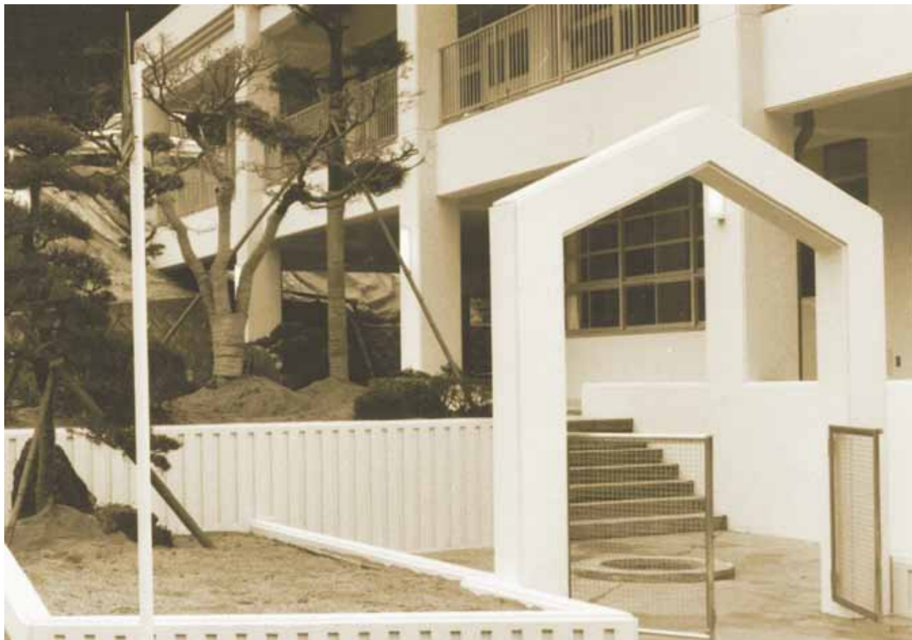
当時の学校施設では珍しく、天井から採光をとれる校舎となっていました。
