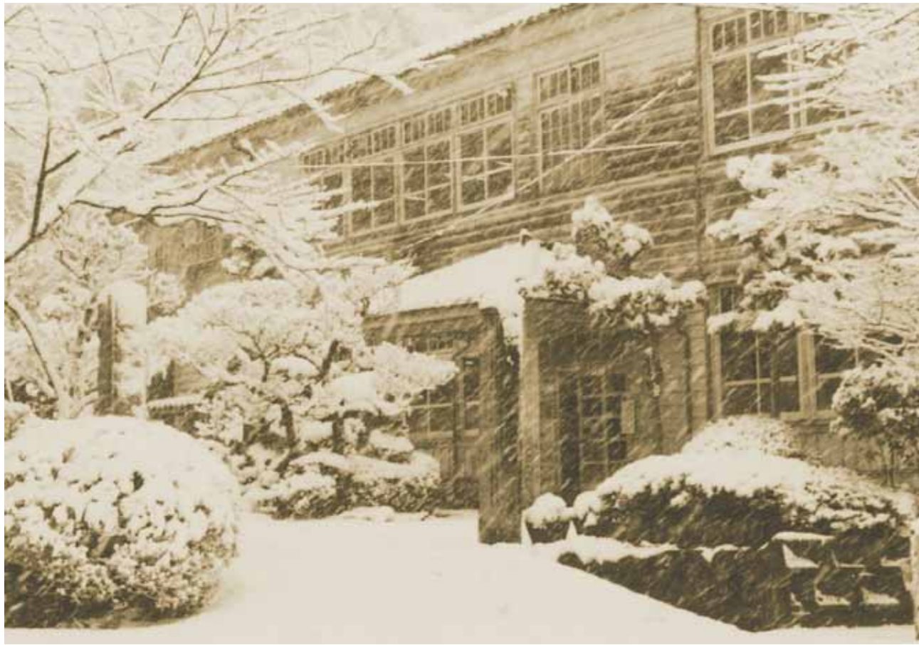
雪化粧に覆われた旧校舎。昭和15年に建築されました。当時は戦争中ということもあり物資が少ないなか建てられました。
