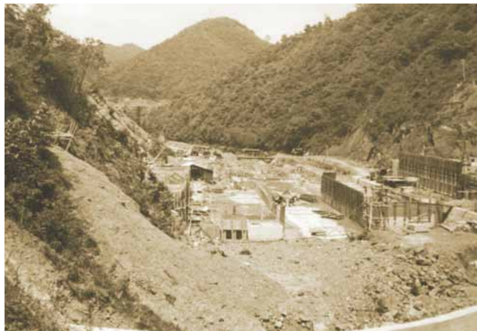
力丸ダム建設中の工事風景。重力式コンクリートのダムとして6年の歳月をかけて完成しました。
