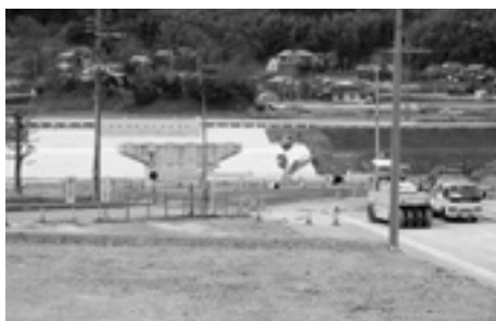
建設中の下口橋
