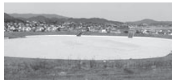
毛勝地区多目的広場
