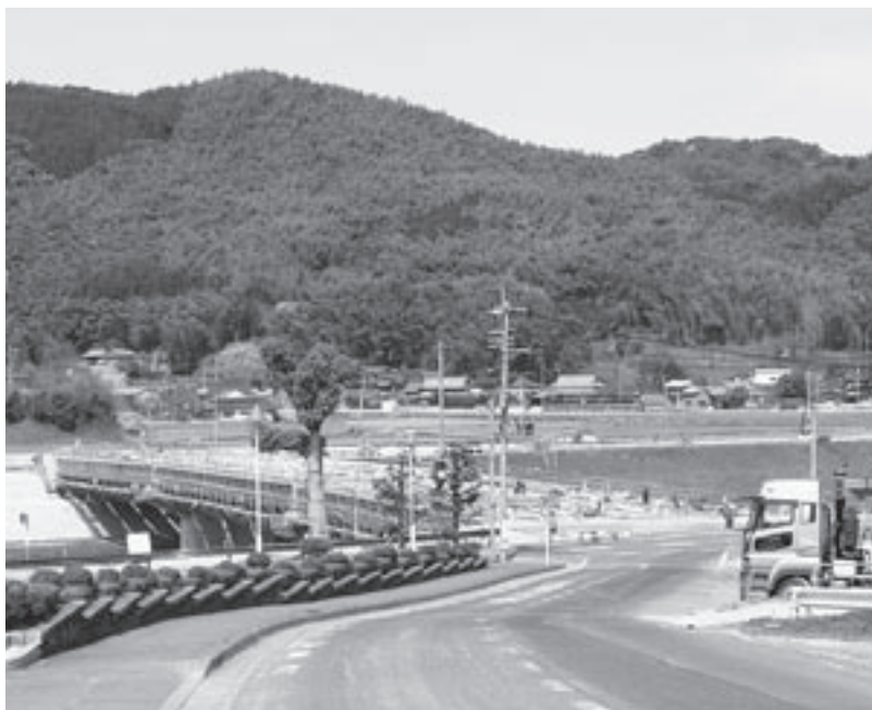
工事中の下口橋
