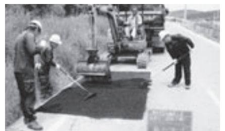
市道の補修工事
