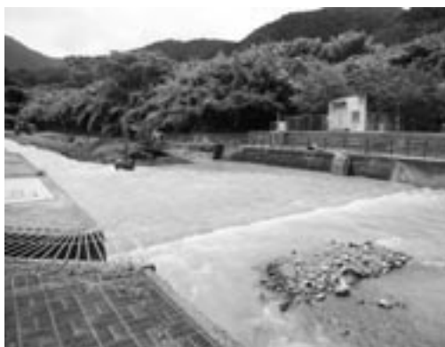
災害復旧工事
