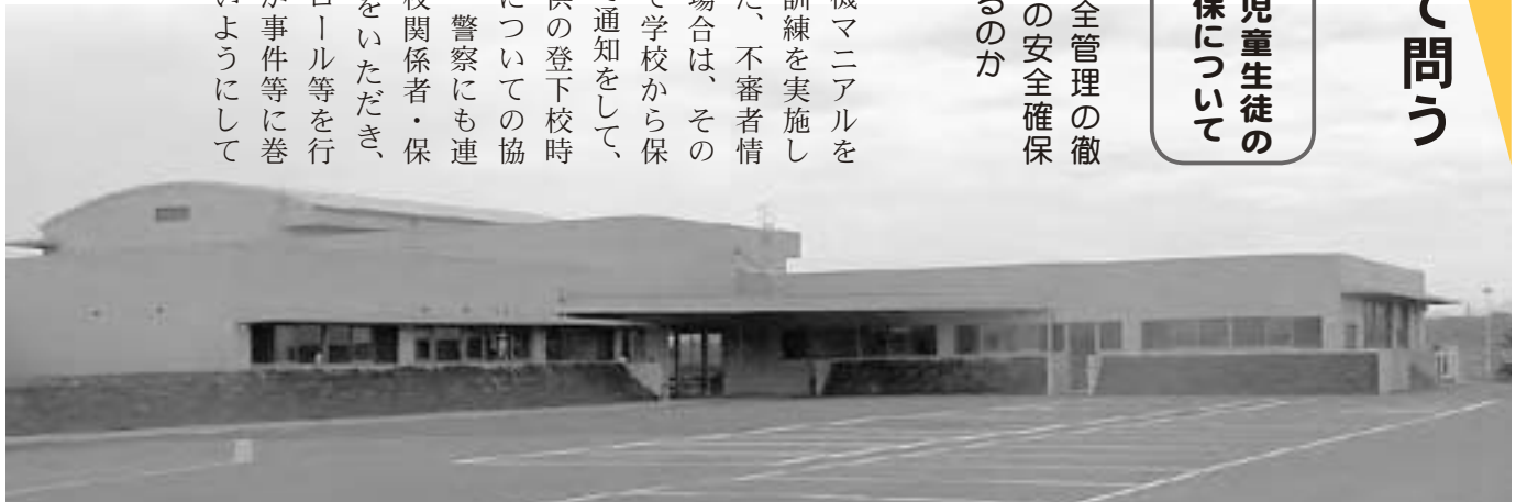
▲全面改築後のパレット
